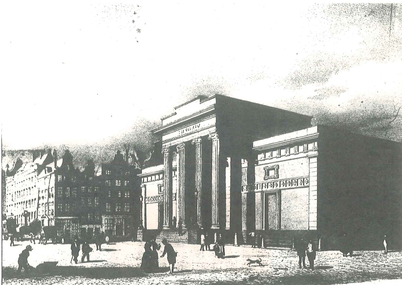
De beurs van Amsterdam gebouwd door J.D. Zocher Jr. Verschillende generaties van de familie Zocher hebben meer naam gemaakt als tuinarchitecten dan als architecten.
