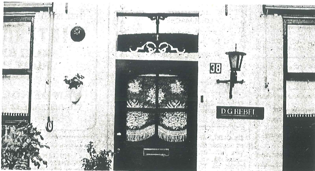
De stenen „tienponder” prijkt naast het bovenlicht van de woning Zeeweg 38.
