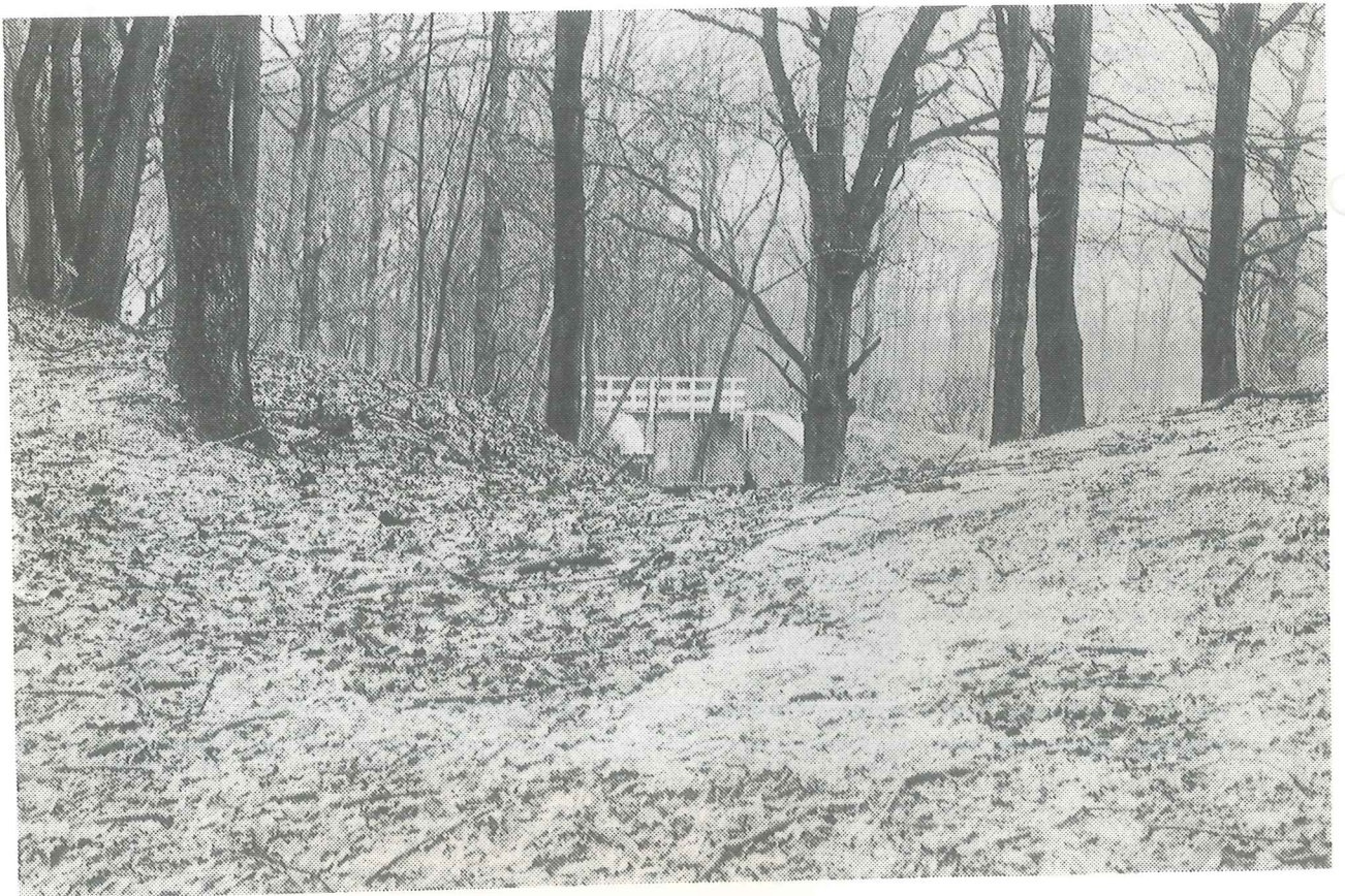
Damsluis na de restauratie.
