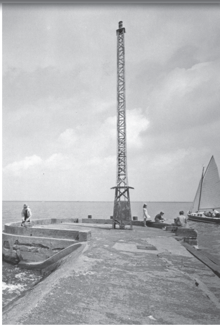
Huizen N.H. Jachthaven en De Pier Gooimeer
