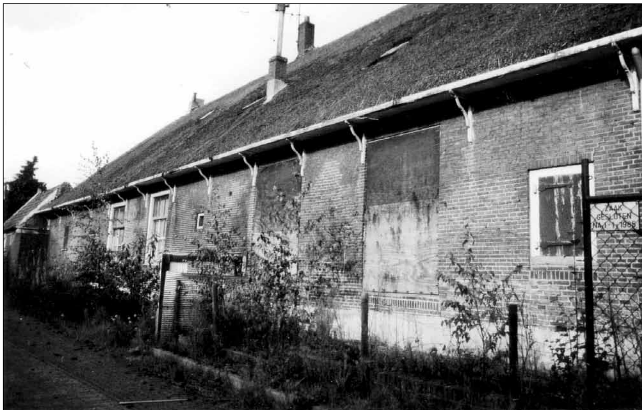
Dicht getimmerd pand 12. Pand 4 ligt achteraan met aangebouwde schuur (uit een latere periode). De panden 6 en 10 zijn met hun voordeur aan de voorkant gelegen. Het pand 8 was al afgebroken en lag aan de Middenweg.
