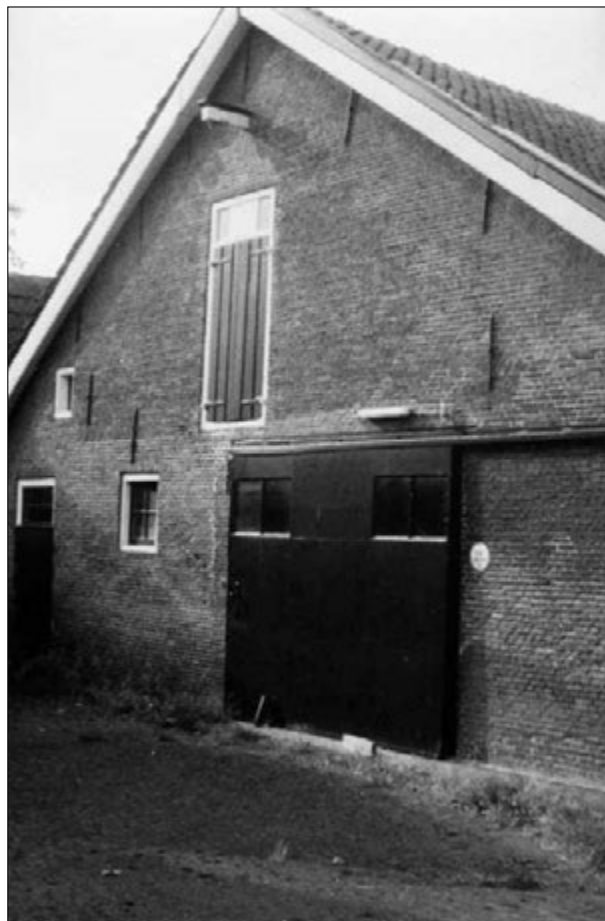
Schuur van Kos met moderne roldeur. Nog wel aanwezig het luik waarmee de voorraden naar de zolder werden gebracht.
