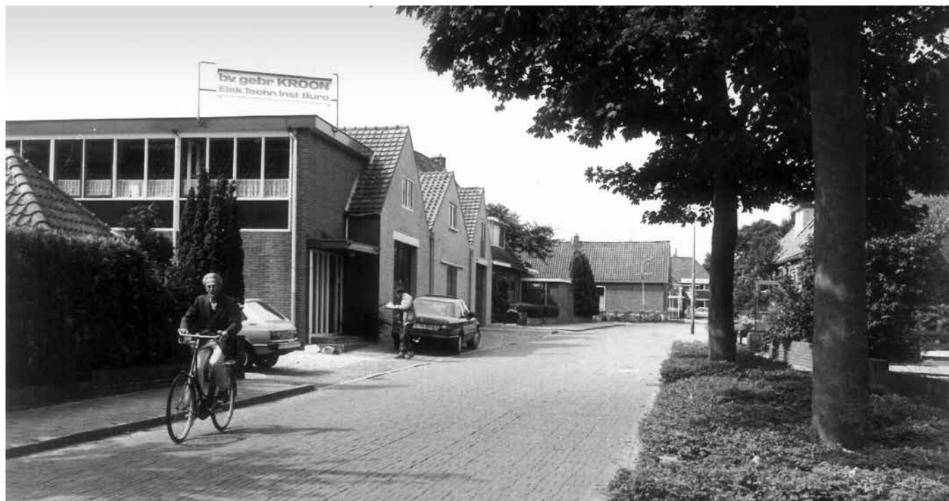
Pand E. Ludenstraat 42-44, de voormalige timmerfabriek.
