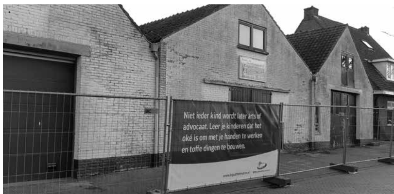
Timmerfabriek E. Ludenstraat 42-44 voor de sloop.
