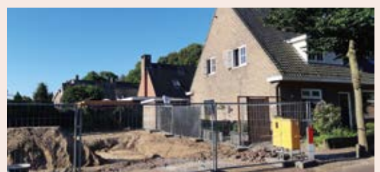
Na de sloop.
