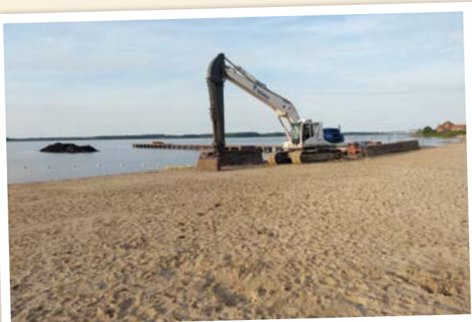
Tot slot een foto van een echte toevoeging aan de Zomerkade, de zwemsteiger in aanbouw op 22 mei 2022 (foto: Rienko Verboon).
