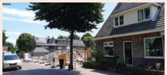
Het pand E. Ludenstr. 40 met daarnaast de brokstukken van de sloop.
