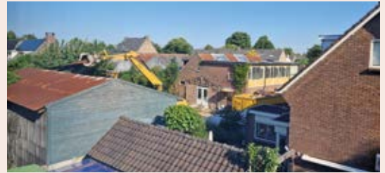
Eerst werd de oude schuur achter het pand gesloopt.
