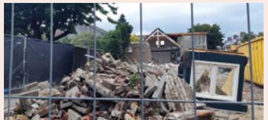
Achterkant van de voormalige timmerfabriek, gezien vanaf de plek van de oude schuur.
